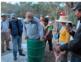
5.-Compactacion de la mezcla.
